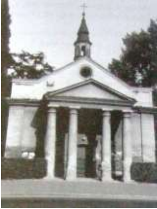
Ryc. 1. Zaniehbana i opuszczona kaplica cmentarna, 1974 [4]
